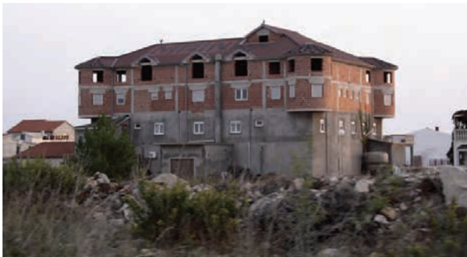
Slika 12. Hrvatska: Neformalna gradnja namenjena za komercijalnu upotrebu u naselju Vir
